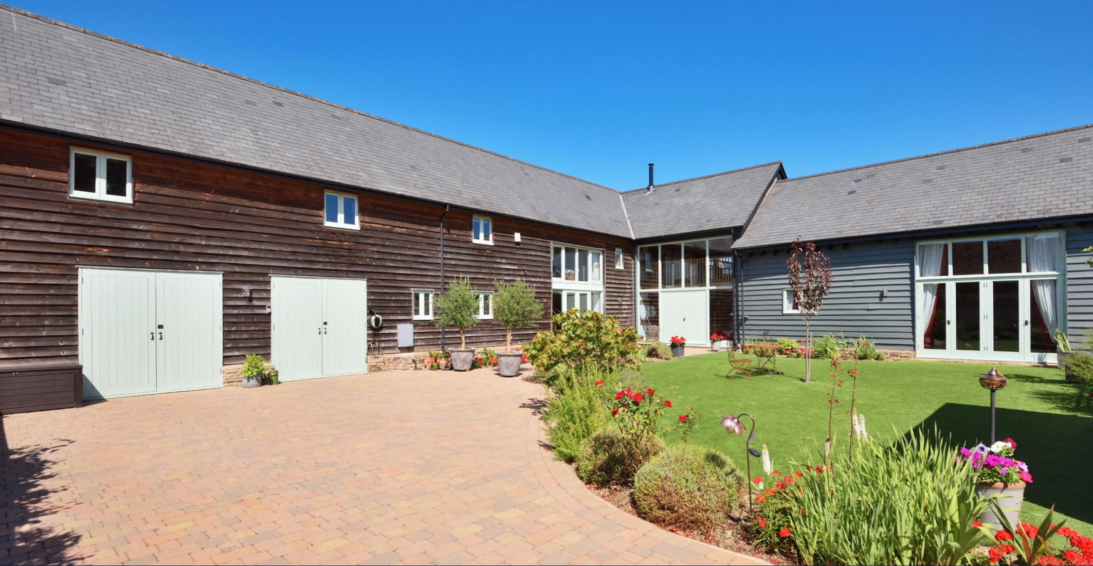
THE CRUCK BARN Pembridge, HR6 9JE
