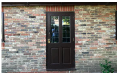
4 Timber framed door
