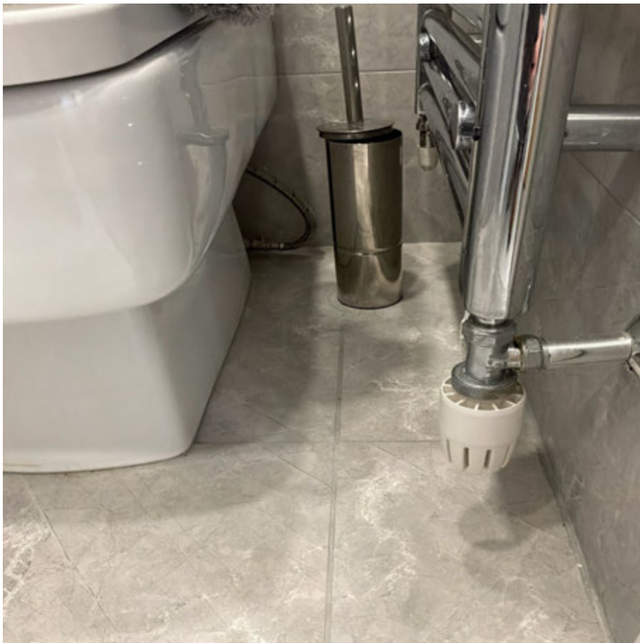
Bedroom 4 Ensuite – 1 no. toilet brush
