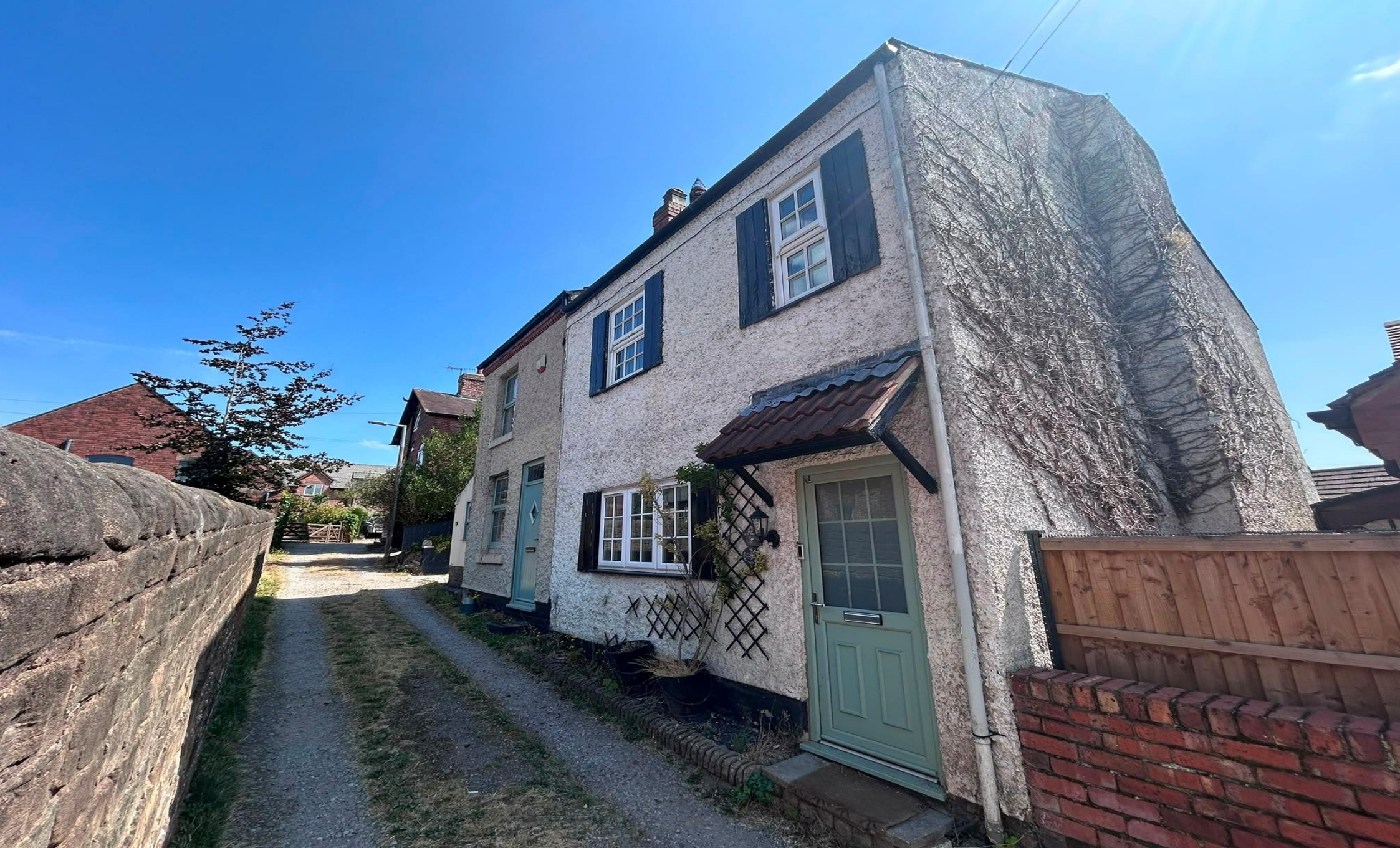
Critchs Flats Kimberley Nottingham
