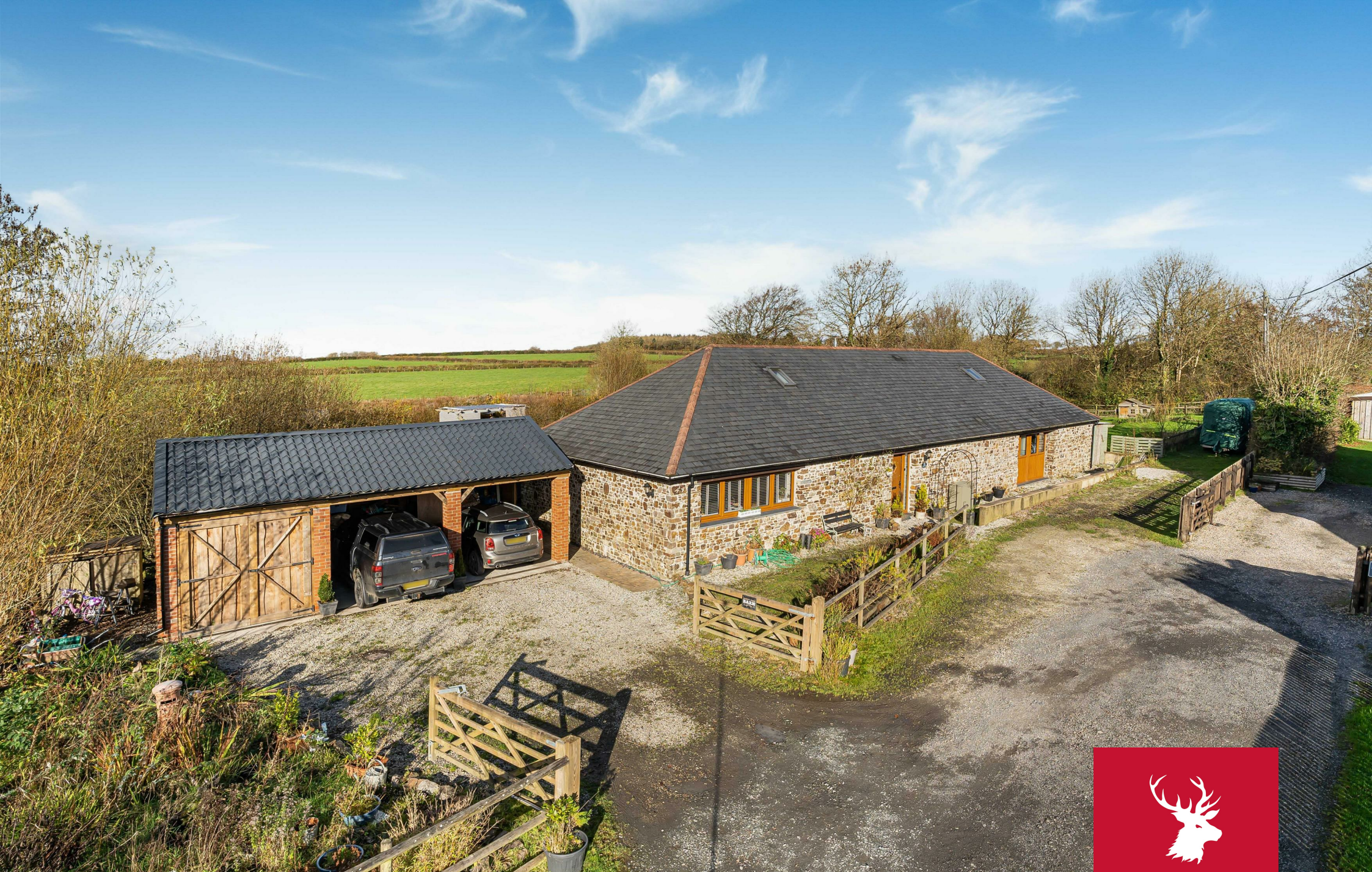
Blagdon Wharf Barn
