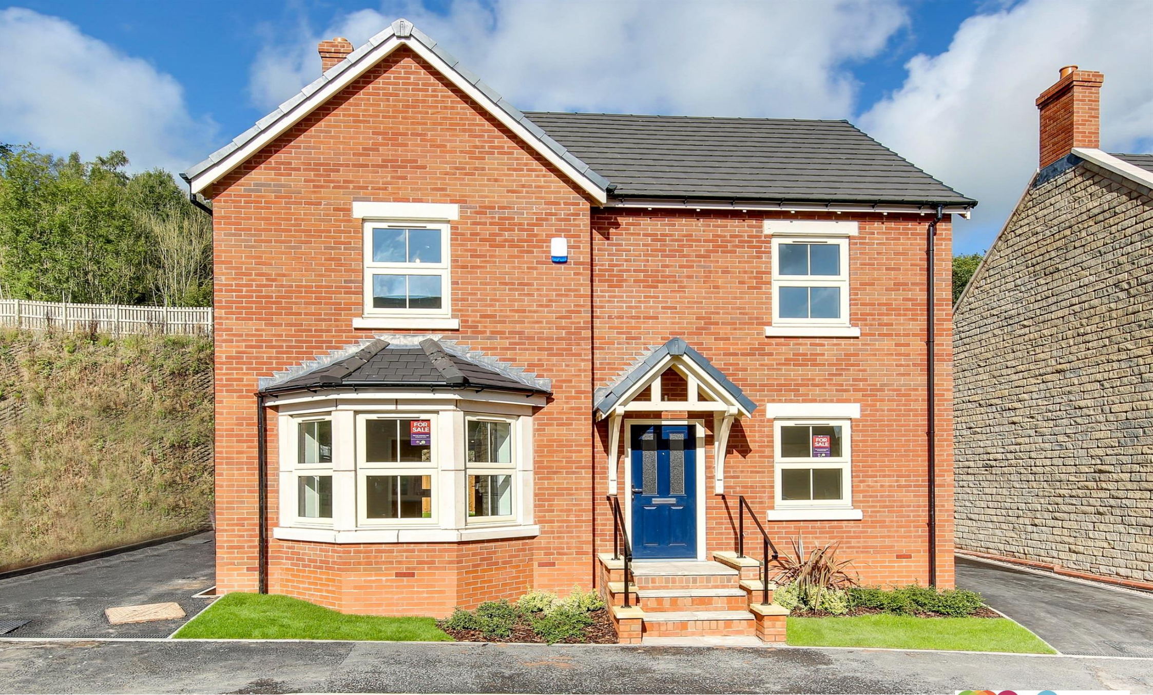
The Rowan Bull Bridge, Ambergate Belper DE56 2EW
