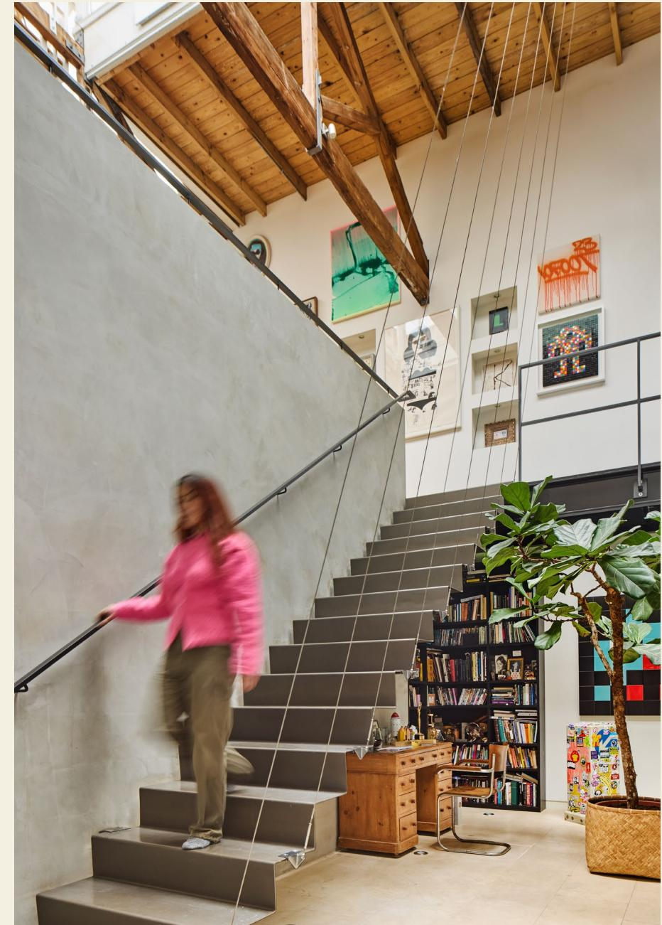
→ A SUSPENDED STEEL STAIRCASE RISES FROM THE TRIPLE-HEIGHT ATRIUM
