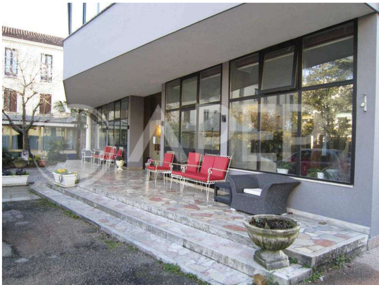
Veduta esterna dell'ingresso
