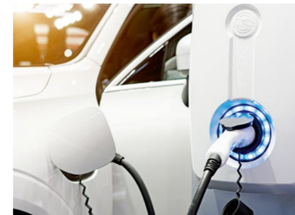
Tiefgarage mit E-Ladestation und barrierefreien Aufzügen. Underground carpark with e-vehicle charging station and barrier-free elevators.
