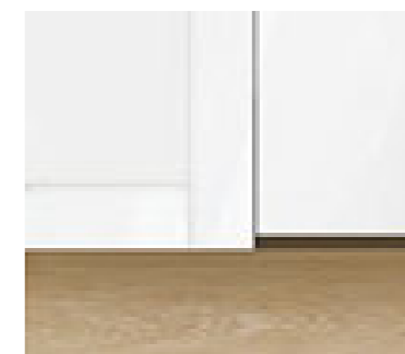
Sockelleiste: flächenbündig mit Schattenfuge, weiß lackiert
