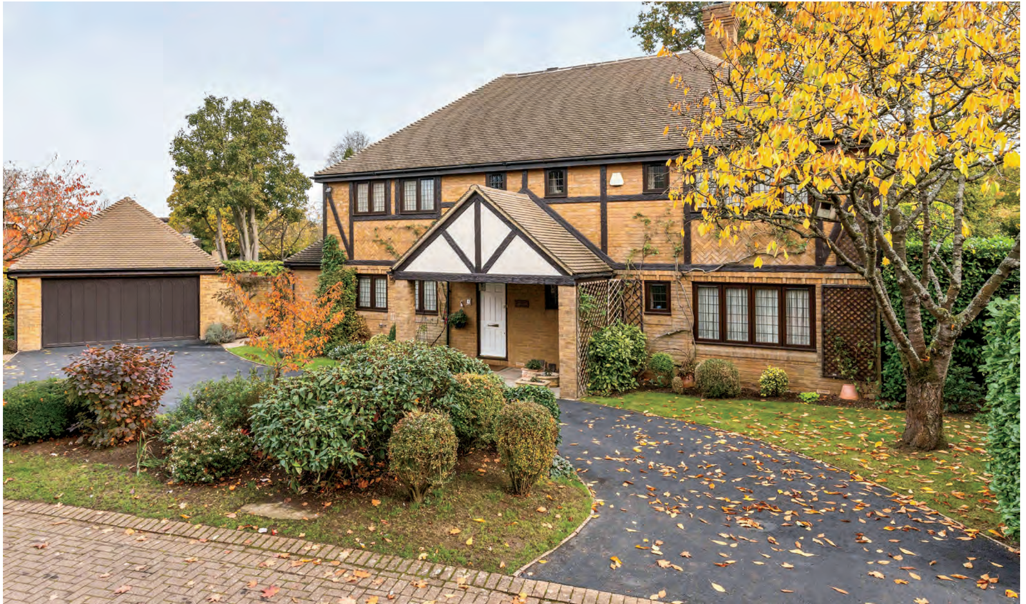
Marigold Cottage 1 St. Marys Close | Aston | Nr Stevenage | SG2 7EQ
