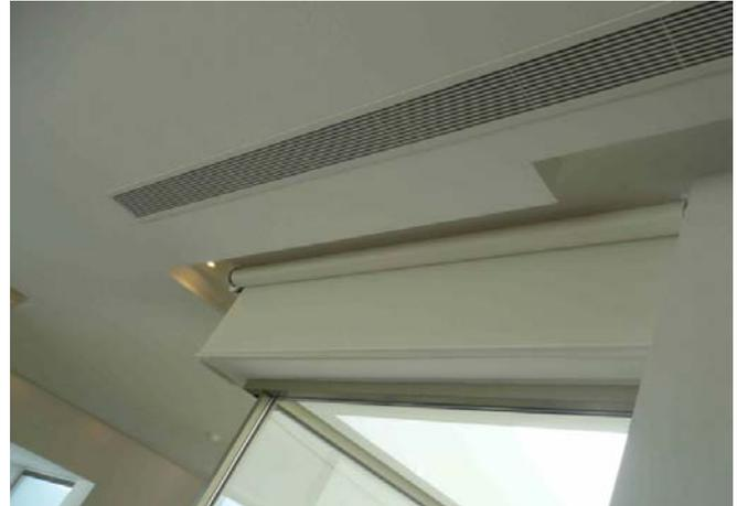
Falso techo registrable de placas de escayola, con perfilera vista en cuartos de baño para ocultar maquinaria aire acondicionado.
