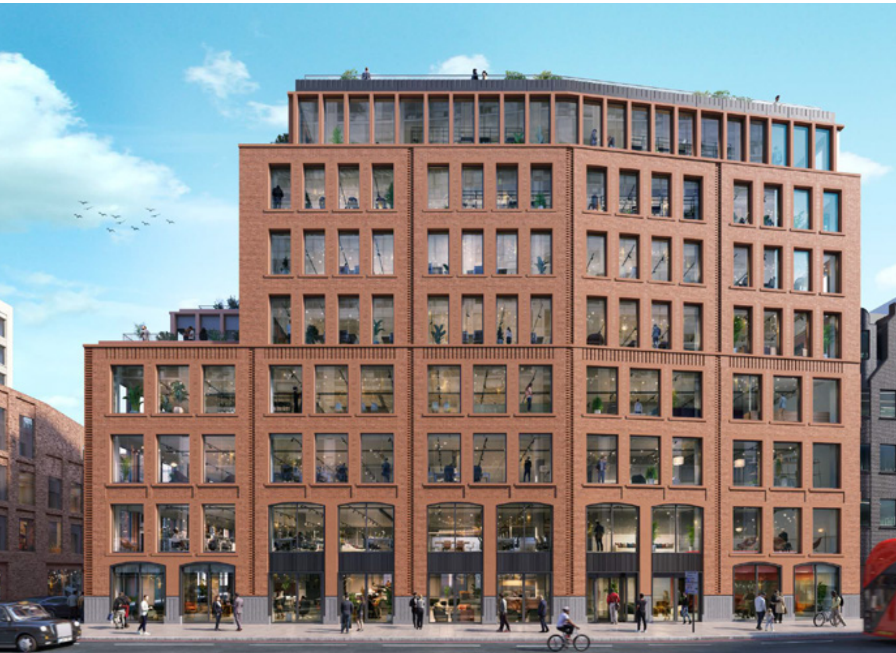
FOLGATE BUILDING LONDON E1
