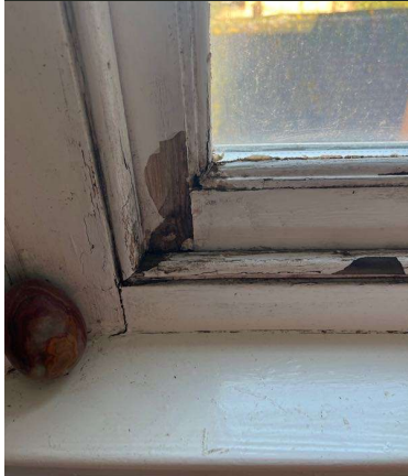
22-11-2024 10:59 / Bedroom Windows Sills / Dezy7na5i
