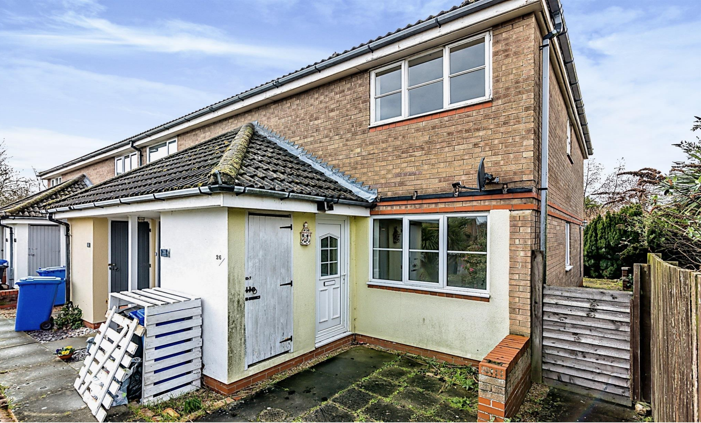
Gondree, Carlton Colville Lowestoft NR33 8UE
